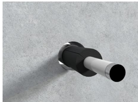
3. Abschließend den Ringspalt um das Rohr im Bauteil mit 1000 Brandschutzkitt, SIBRALIT DX, Mörtel oder Gips gemäß Kapitel 4 verfüllen.
