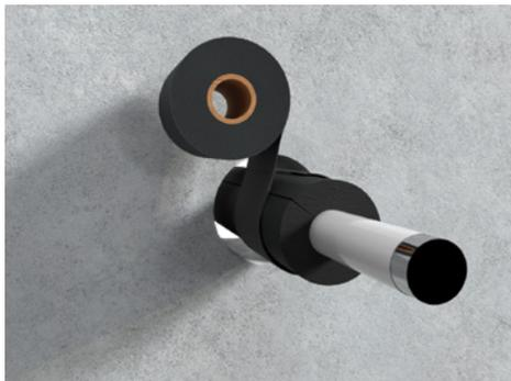
2. Die einzelnen Wicklungen untereinander durch Abziehen der Schutzfolie verkleben. Bei nicht selbstklebender Variante ist die letzte Lage mit Klebeband zu sichern. Anschließend das Band ins Bauteil schieben.
